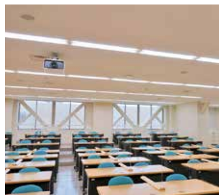
講義室の窓面に設置された鉄骨ブレース
