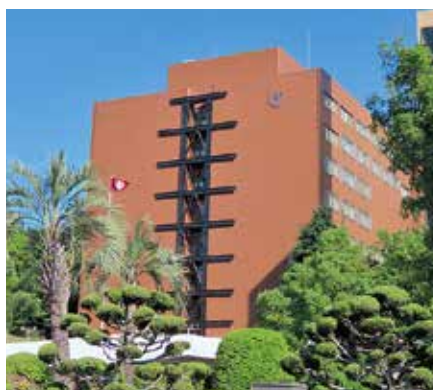
外壁面に設置された鉄骨ブレース
