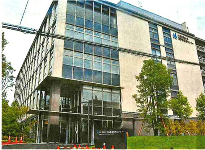
完成した新病院「川崎医科大高齢者医療センター」
