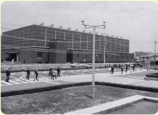
総合体育館 昭和56年5月
